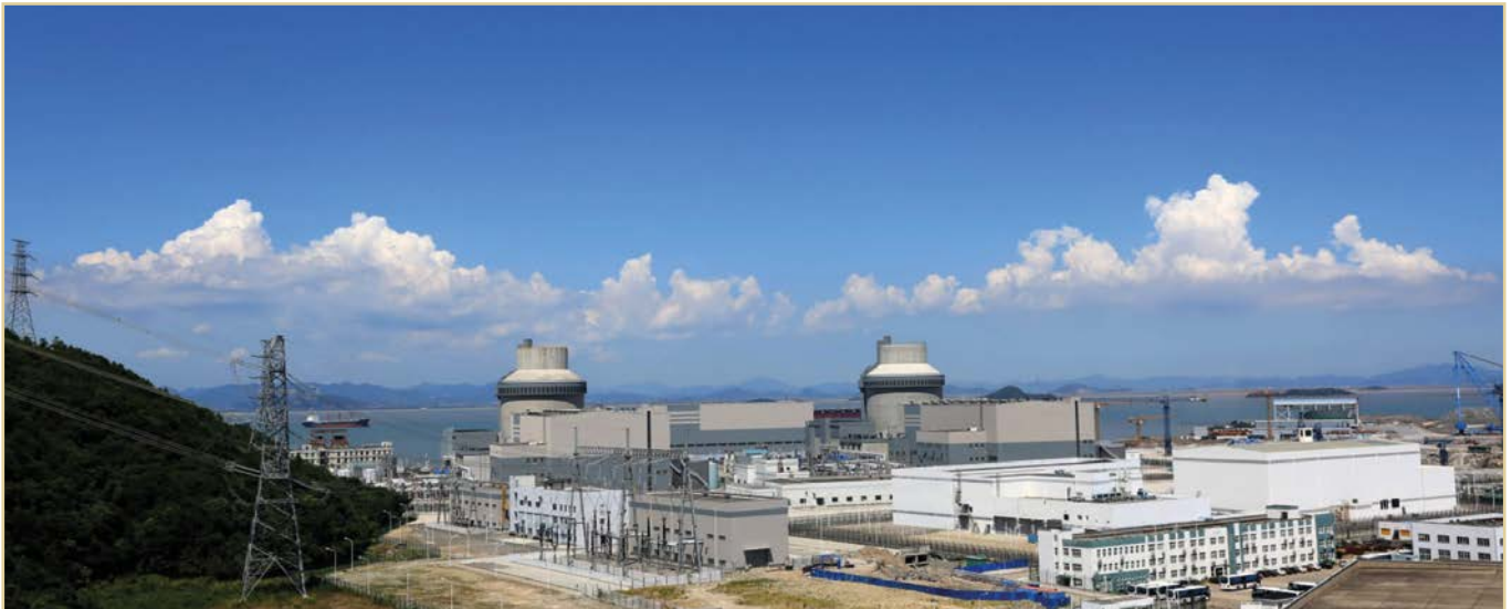
Figura 7. Central de Sanmen (China) – Primer Reactor AP1000
