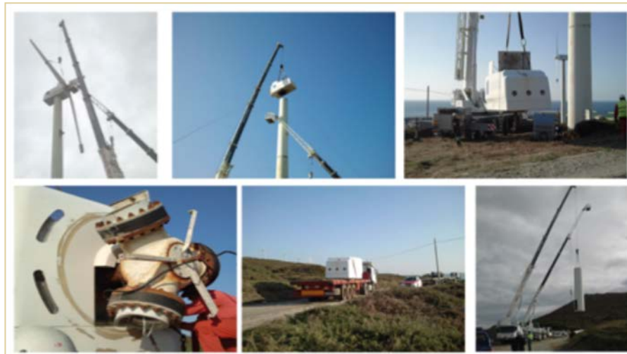
Figura 8. Imágenes de secuencia de desmontaje de aerogeneradores en Cabo Vilano
