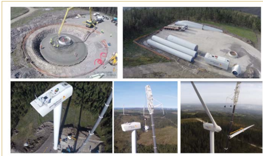
Figura 9. Imágenes de secuencia de instalación de nuevas máquinas del mismo tipo que las que se instalaron en Cabo Vilano (ejemplo Parque Eólico Cordal de Montouto, con puesta en marcha en el año 2014)
