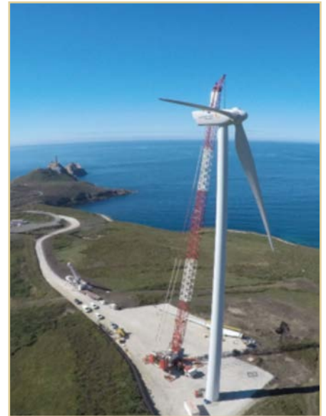
Figura 10. Montaje aerogenerador Cabo Vilano, agosto 2016
