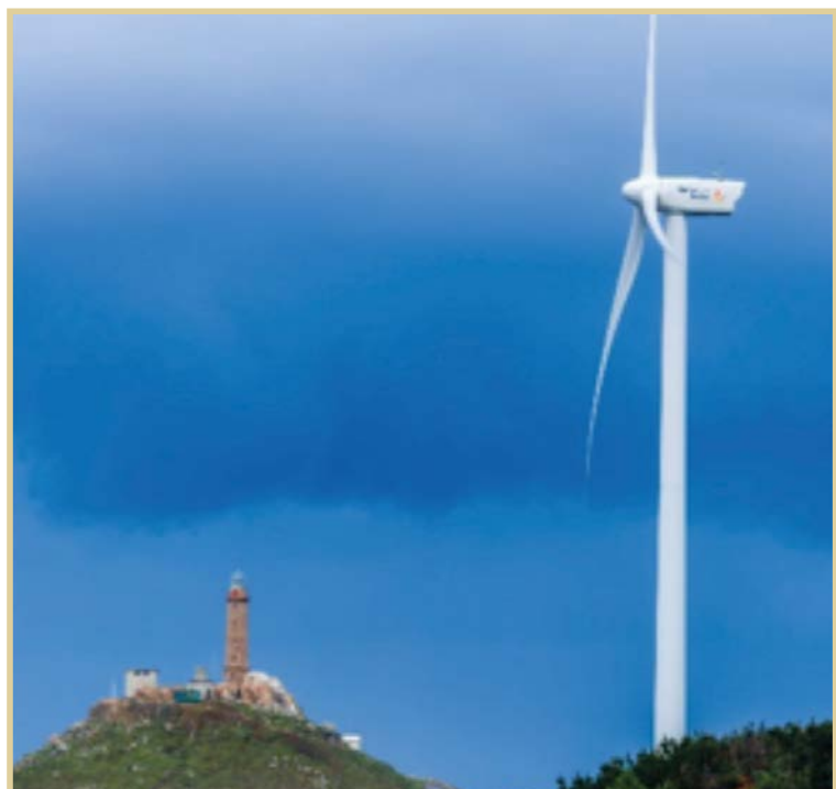
Figura 1. Imagen de aerogenerador de la repotenciación del parque eólico de Cabo Vilano, con faro al fondo
