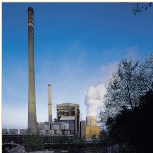
Figura 3. Central térmica de Soto
